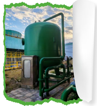
冷却循环水旁滤系统
