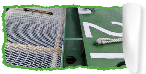
平台直升机甲板收集雨水槽
