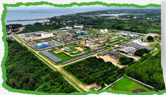
涠洲油田群光伏电站
